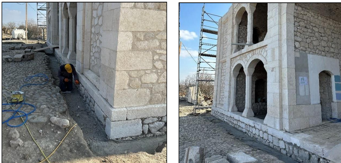
Рис 6. Усиление фундаментов.
