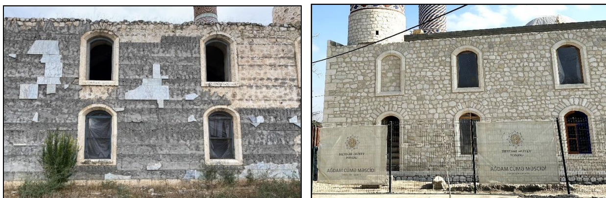
Рис 4. Вид бокового фасада до и после реставрации.
