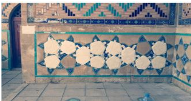
Сурет 5 – Кесененің құрылыс материалдарындағы тұзды шөгінділерді жоюға компресс тәсілінің қолданылуы
