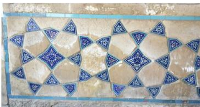
Сурет 4 – Кесененің сыртқы бөлігіндегі тұзды шөгінділердің түзілу көрінісі
