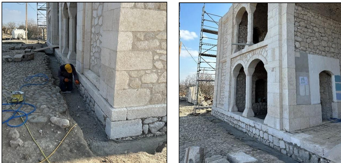
Рис 6. Усиление фундаментов.
