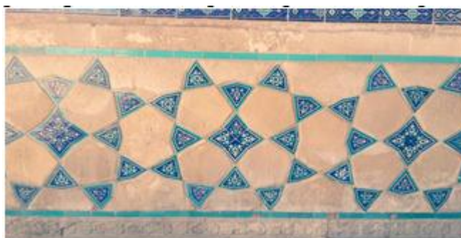
Сурет 6 – Гидрофобизациялау процесі жүргізілгеннен кейін тұздардан тазартылған бөліктің сыртқы көрінісі
