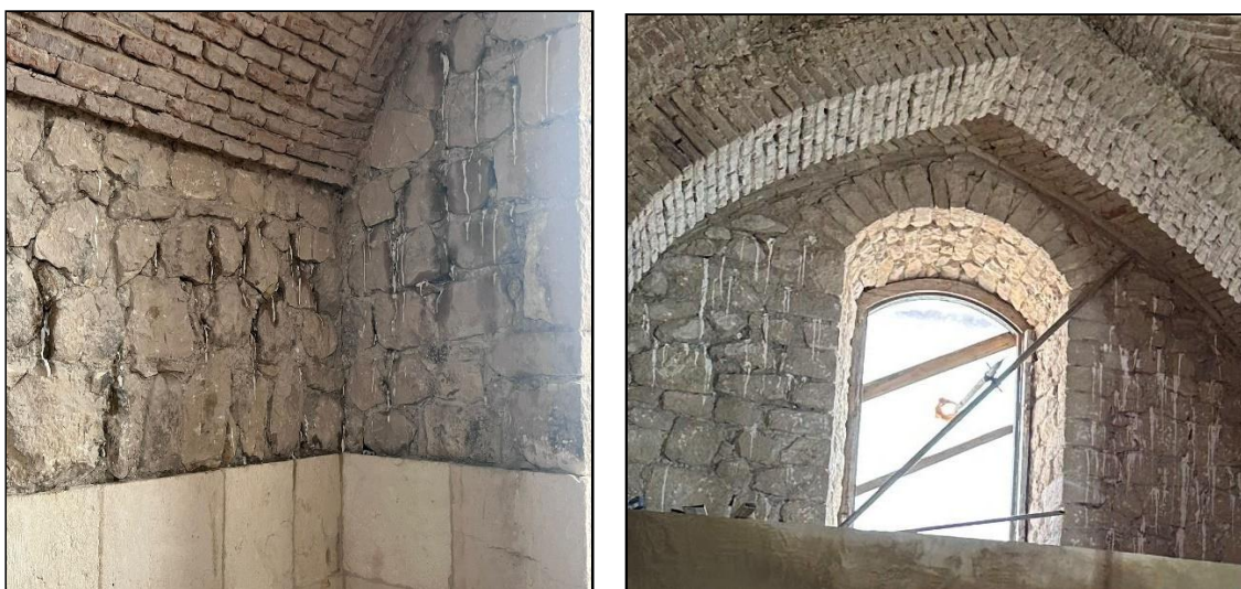
Рис 5. Усиление стен, заполнение пустоты в теле кладки известковым инъекционным раствором.
